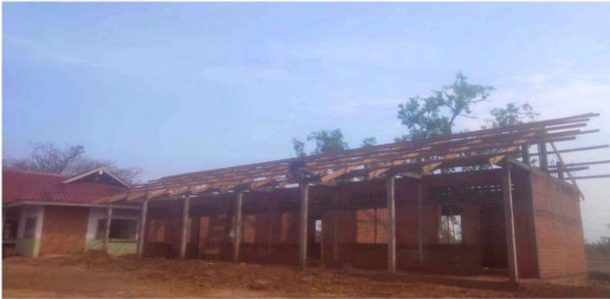
Der Erweiterungsbau wird in unmittelbarer Nähe des bestehenden Schulhauses erstellt,
