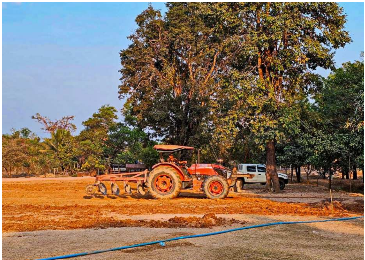
Im Sommer 2024 wurden die Sanierungsarbeiten beim Okheon-Sportplatz aufgenommen, damit dieser rechtzeitig als Stadion für die laotischen Jugendspiele genutzt werden kann.
