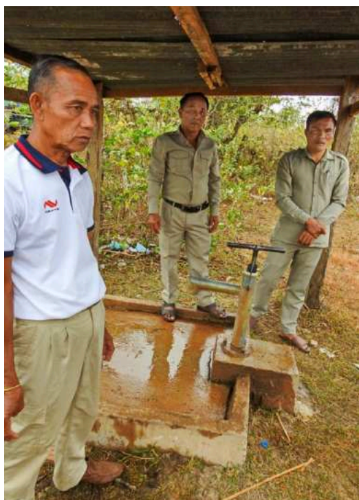
Mit einem einfachen Ziehbrunnen wird die Fassung relativ sauberen Wassers gewährleistet.
