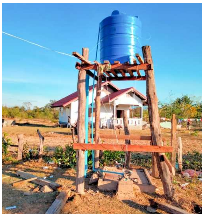
In unmittelbarer Nähe des Schulhauses wird ein Wasserreservoir für die sanitären Anlagen und die Dorfbevölkerung erstellt.
